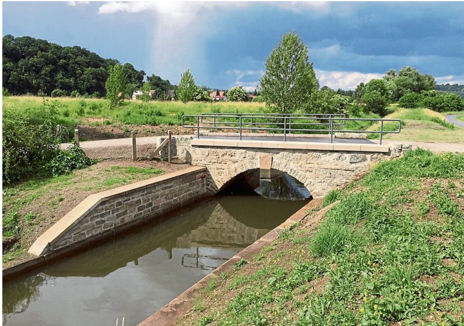
Im thüringischen Crossen wurde mit der Sanierung des historischen Elsterflossgrabens bereits begonnen.
