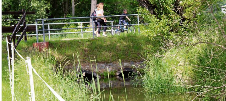
Um die Grundstücke in Ahlendorf vor einem Elster-Hochwasser zu schützen, will das Land parallel zum Floßgraben eine Hochwasserschutzmauer errichten.
