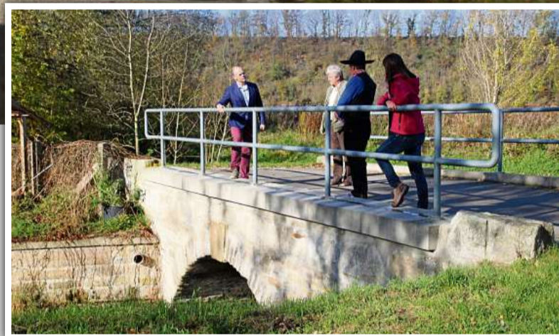
Auf der restaurierten Floßgrabenbrücke.
