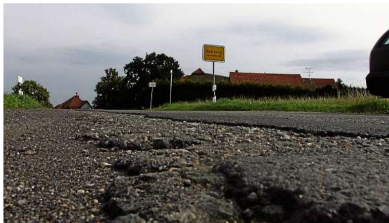
Immer wieder in der Vergangenheit nur notdürftig geflickt: Die marode Kreisstraße in Bollberg.
